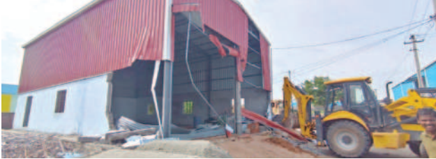
అక్రమ నిర్మాణాలను జేసేటోత్ కూల్చివేస్తున్న రెవెన్యూ అధికారులు
